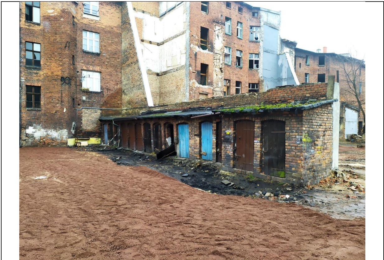
Fot. 1. Widok ogólny
